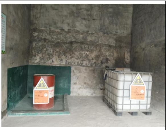
图 2 现有项目危废仓内景
