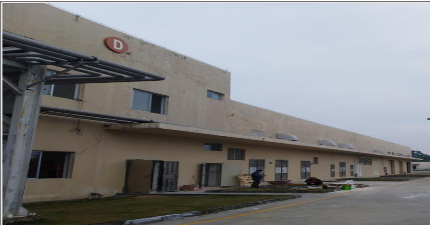
项目东面（原辅助用房一层（空压机房、维修、消防水泵房等）
