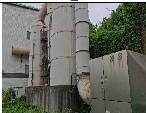
DA004 介质土发酵厂房——“生物喷淋塔+UV 光催化”
