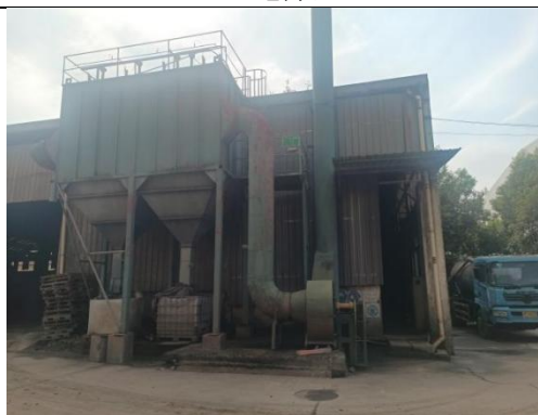
DA005 环保烧结砖厂房（窑炉废气）——生物水洗喷淋塔+氧化法脱销+石灰-石膏法脱硝+湿电除尘
