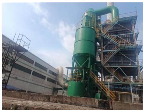
DA005 环保烧结砖厂房（窑炉废气）——生物水洗喷淋塔+氧化法脱销+石灰-石膏法脱硝+湿电除尘
