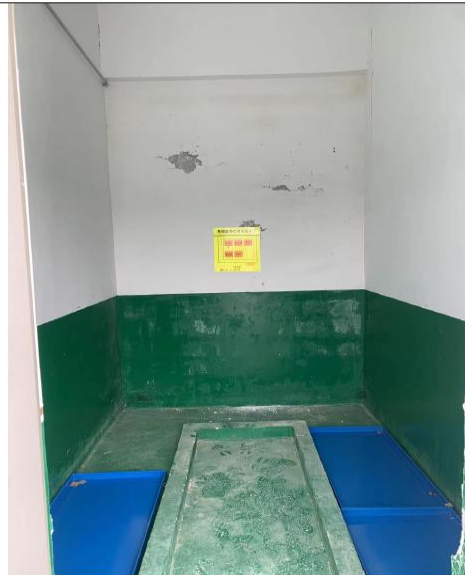
危废房室内照片
