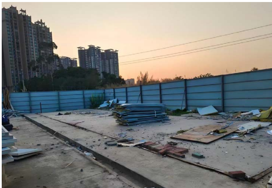
图 4-1 临时用地活动板房拆除现场
