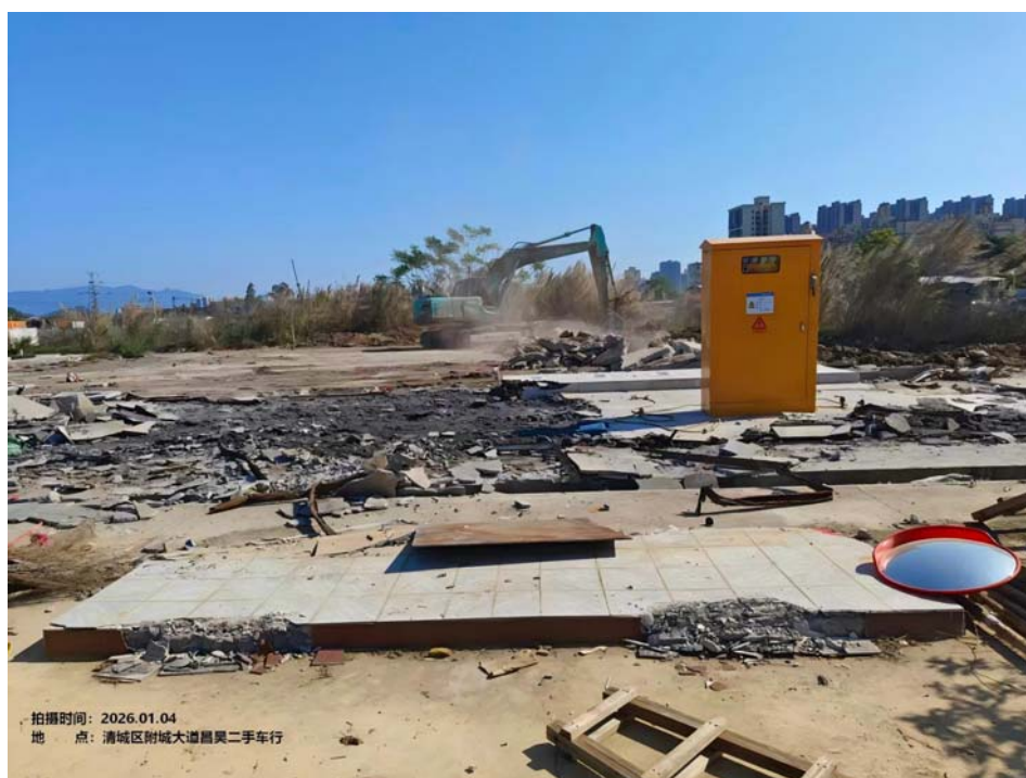
图 4-2 临时用地硬底化清理现场
