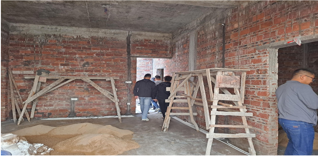
（图 1 二楼内部装修图片）
