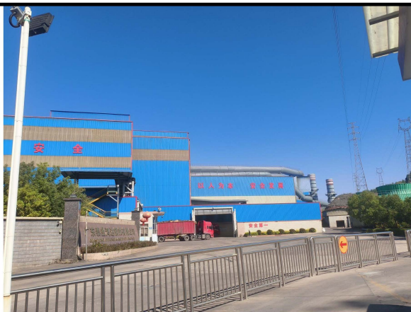
项目东北面（广东泰业鸿达钢铁有限公司）
