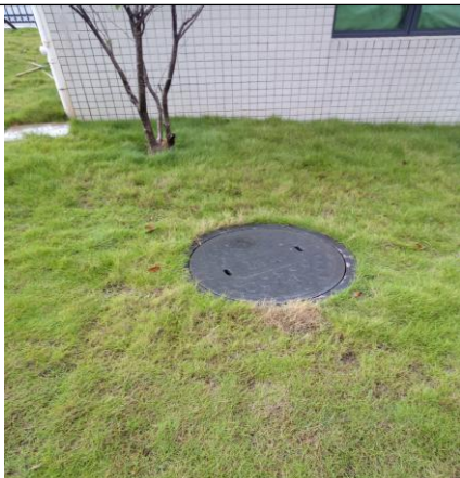
图片 3 厂区污水接驳口
