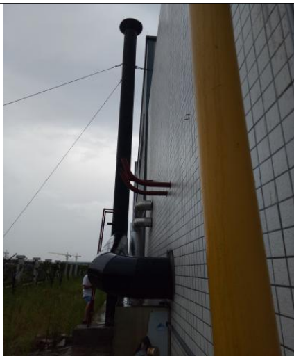
锅炉废气 P1 排气筒
