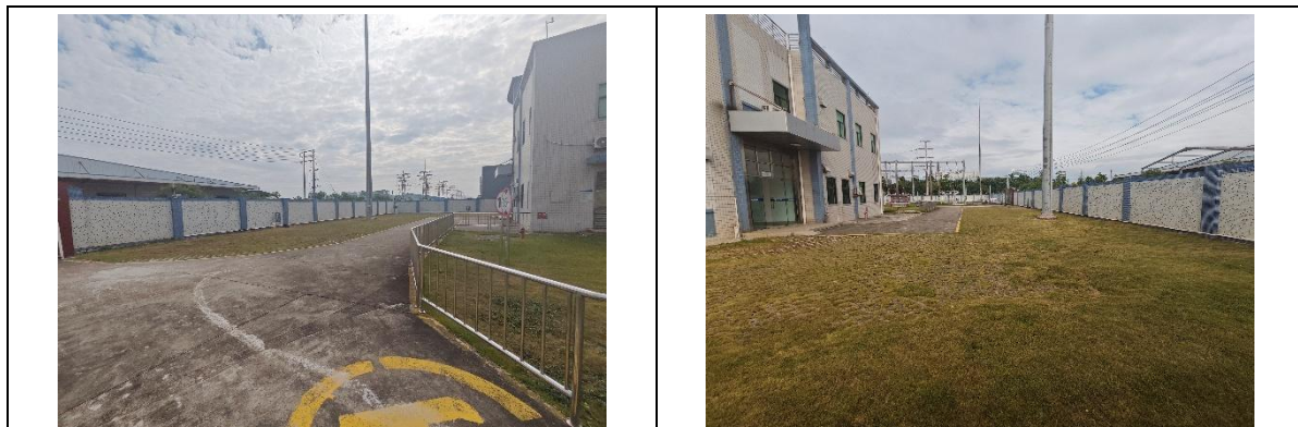
图5 110kV横荷变电站主控楼东侧空地现状
