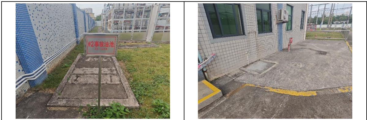
图4 110kV横荷变电站站内事故油池及化粪池
