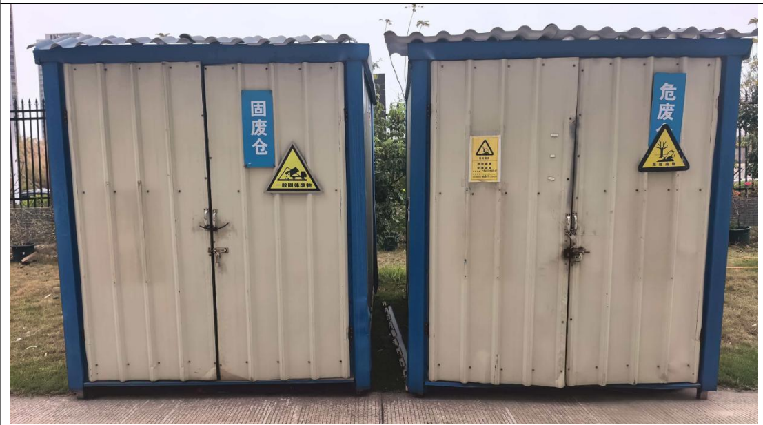
一般固废仓/危险废物暂存间
