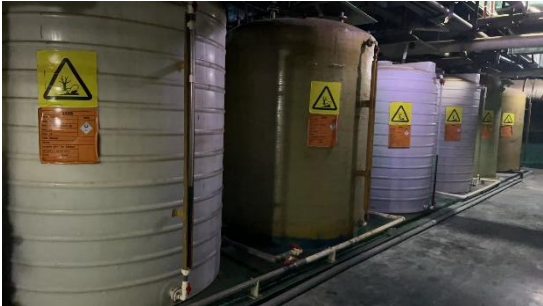
废液储罐区内部
