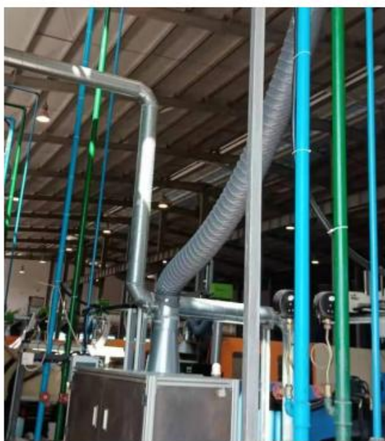
图片3注塑、挤出废气车间废气收集管
